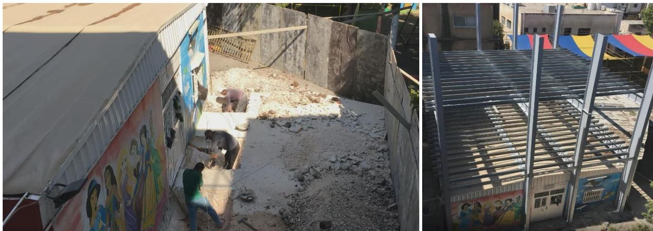
auf neuen Fundamenten eine Stahl-konstruktion erstellen, die den Neubau trägt. So können wir das alte Gebäude darunter weiter nutzen. Eine Aufstockung war wegen der Statik nicht möglich, ein völliger Neubau unbezahlbar. Schon während der Bauarbeiten besuchte uns Bischof Hosam Naoum.
